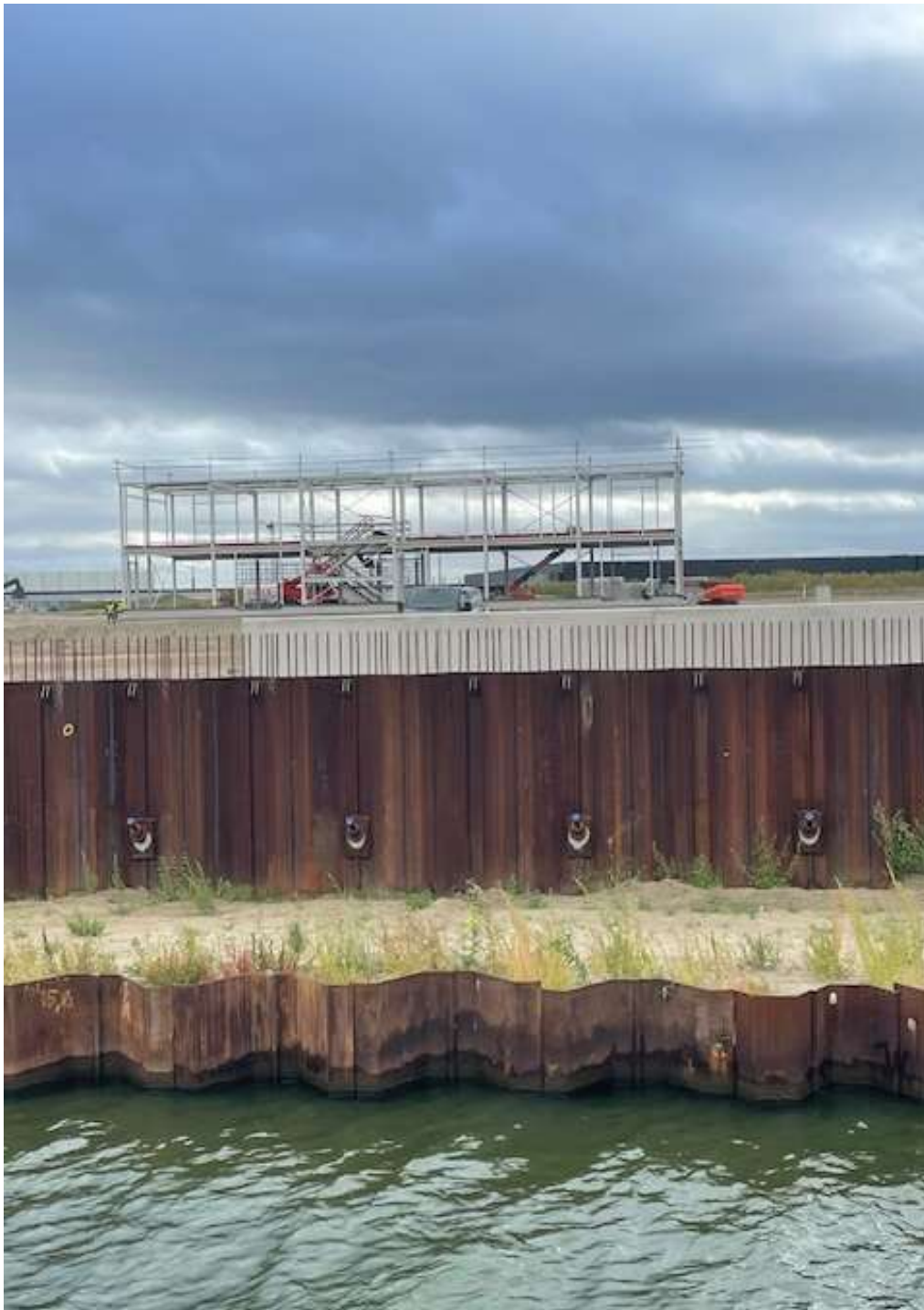
Damwanden zijn klaar. Foto Bram Aertssen
